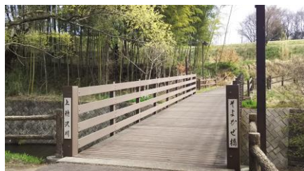
改修された南小通学路のそよかぜ橋
