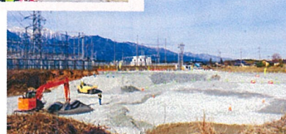
埋め立て跡地造成中と運搬トラック
